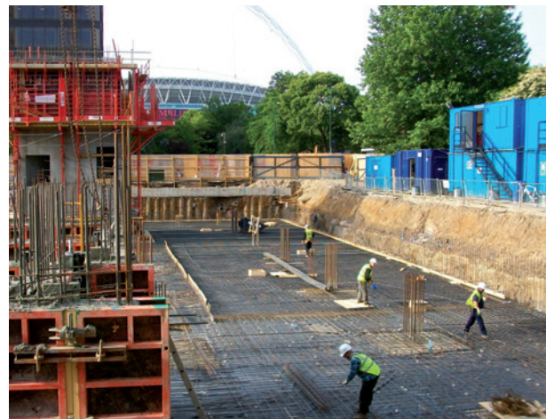
Preparing to pour the watertight floor slab
